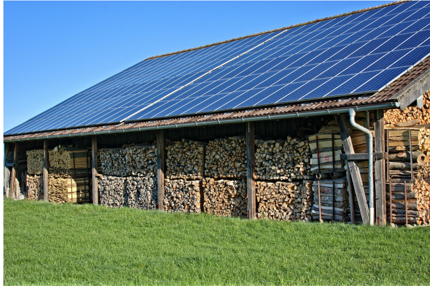
Abbildung 1: Aufdachanlage: Photovoltaik-Module auf einem Dach (Bildquelle: [6])
